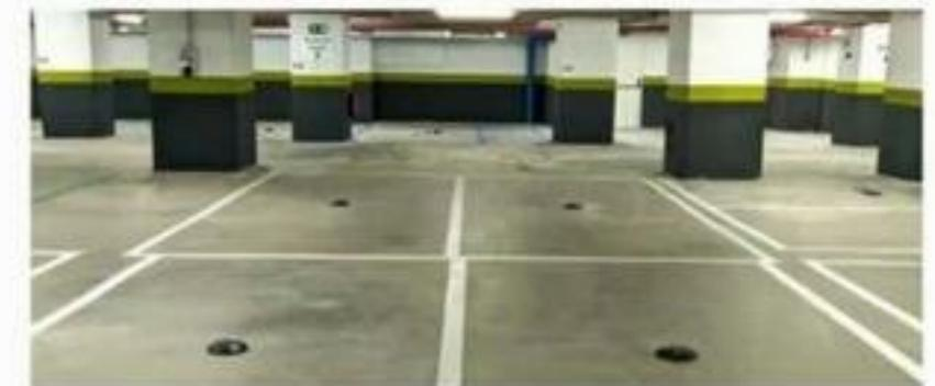
Las sondas instaladas en el suelo utilizan el protocolo LoRaWAN para enviar la información de ocupación a la plataforma IoT
